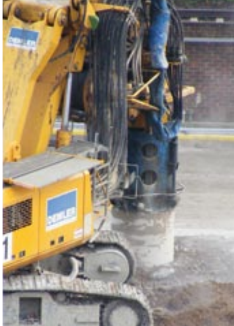
Gründung der Bohrpfahlwand bis zu 20 Meter tief
