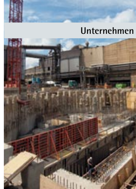
Der Hydraulikkeller kurz vor seiner Vollendung
