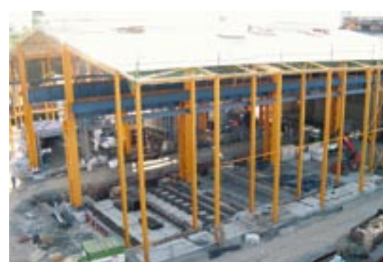
Stahlkonstruktionen der neuen Halle am 30. 5. 2009
