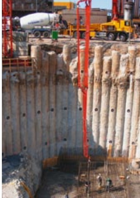
Am 16. 4. 2009 wird der Pressenkeller betoniert
